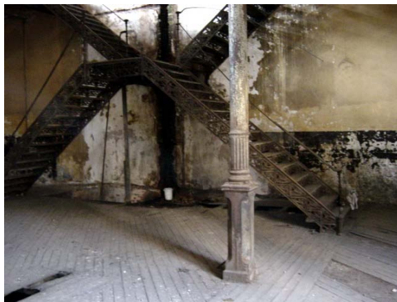
Detall d'una de les columnes de ferro forjat de l'interior de la part noble de la fàbrica de can Ricart
