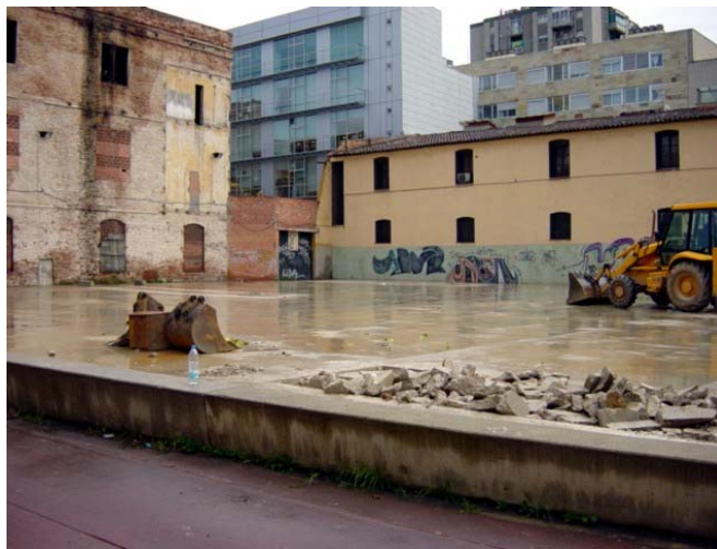
Vista general des del nord-oest de la zona de la intervenció
