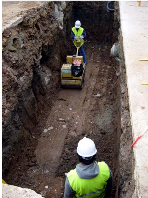
Treballs de compactació per capes durant el reompliment de les rases
