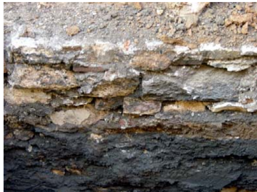
Rasa 6. Detall d'un mur de fonamentació de les antigues dependències de la fàbrica
