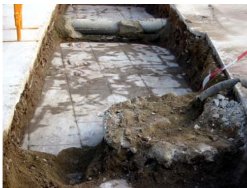
Restes del paviment de pòrtland documentat a la Rasa 1 i afectat per conduccions de serveis posteriors.
