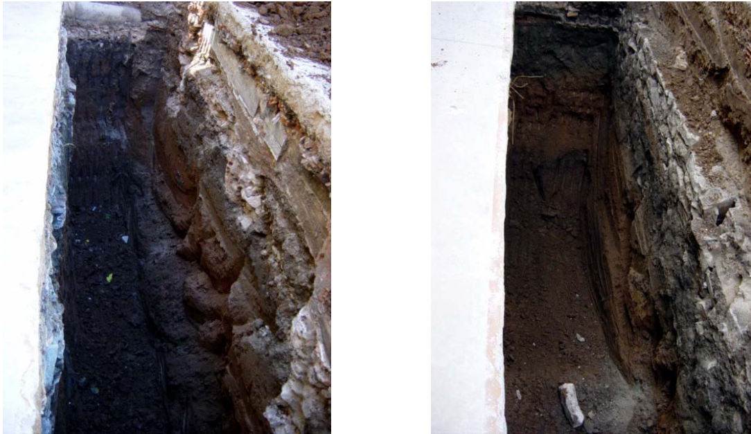
Vista general de les rases 5 i 6 un cop finalitzats els rebaixos. L'estratigrafia presenta iguals característiques que la resta de sondejors.
