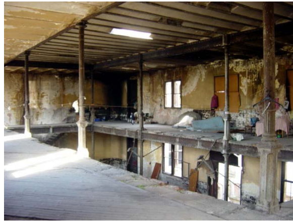
Vista general de la segona planta de la fàbrica
