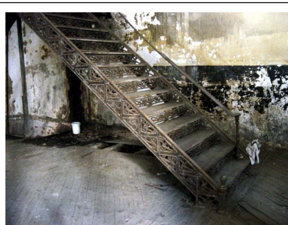
Detall de l'escala de ferro forjat conservada a l'interior de l'edifici de can Ricart.
