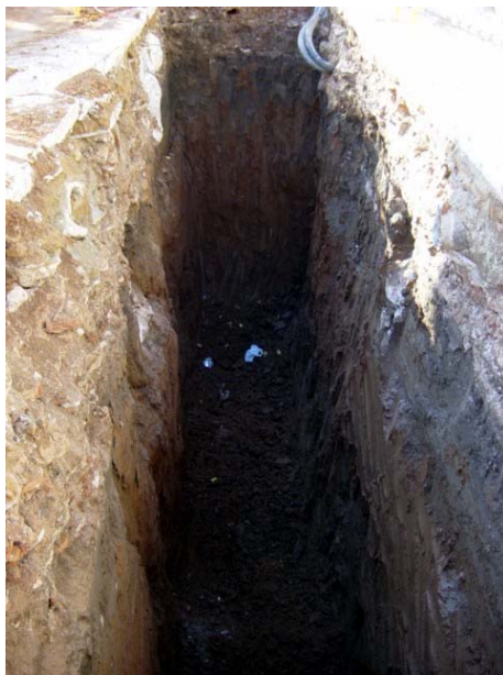
Vista general de la rasa 1 al final del rebaix de 5m. de potència
